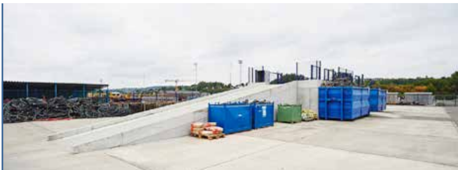
Rampe d'accès (Infrabel, site de Ronet)
