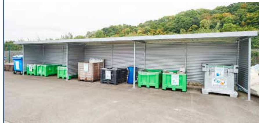
Stockage à l'abri (Infrabel, site de Ronet)
