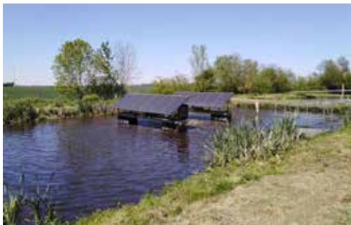
Lagune équipée de panneaux photovoltaïques gérée par l'INASEP
