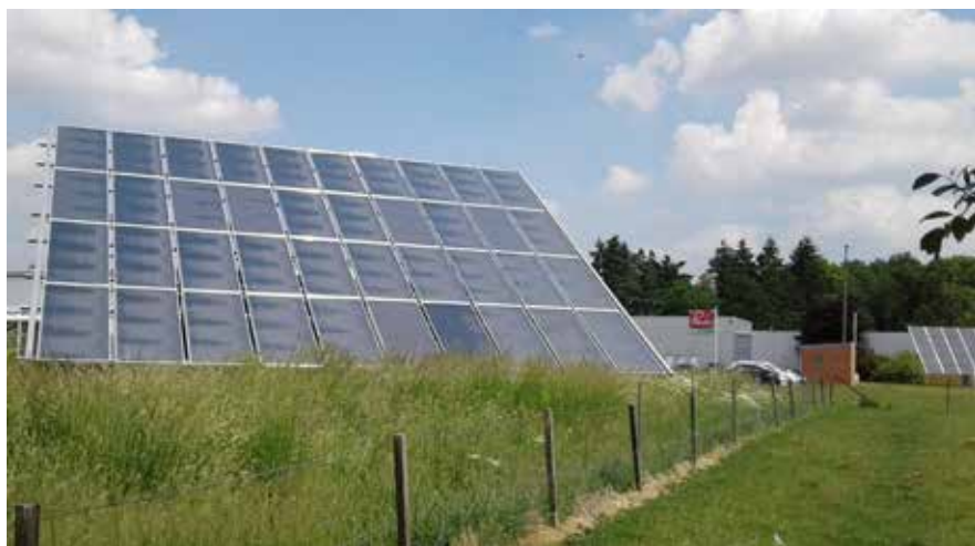
Installation de panneaux solaires
