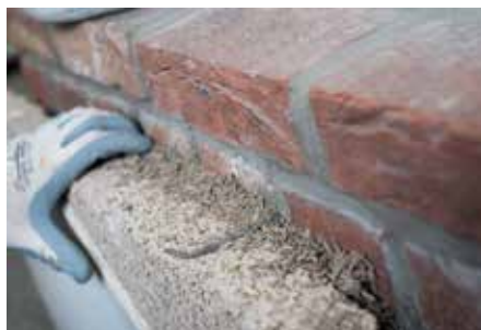
Produits IsoHemp lors d'un chantier de rénovation
