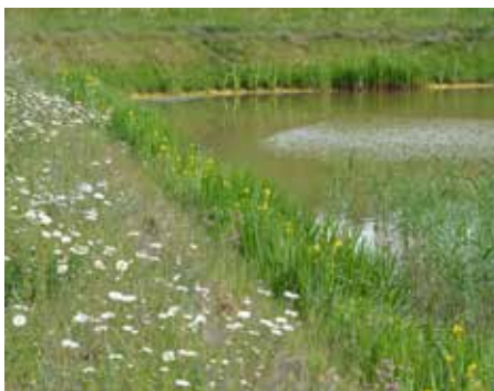
Bassin d'orage du Parc Ecolys ®
