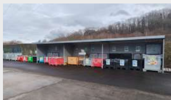
Stockage des déchets à l'abri
