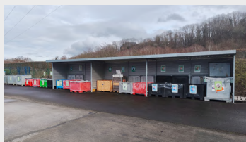
Stockage des déchets à l'abri
